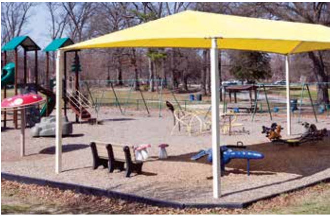
Figura 1 Los dispositivos sencillos de sombra, apoyados en columnas en este caso, requieren mínima estructura. Los toldos se pueden quitar fácilmente en los meses más fríos, reemplazándolos cuando sea necesario por mantenimiento o cambiándolos por colores de temporada.
